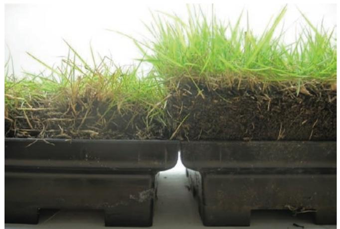
図3：施工後経過年数0年（左）と10年（右）の屋上緑化土壌基盤断面の様子。植物の二酸化炭素固定によって、経年的に有機物が蓄積し、土壌厚が増加している。
