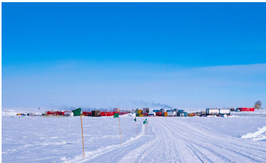
図 1 南極点に建てられ掘削のための蒸気をもくもく上るドリルキャンプ：ドリルキャンプは、発電機や氷を溶かしお湯を作る多くのコンテナサイズの装置から成る (photo: Aya Ishihara/IceHap)
