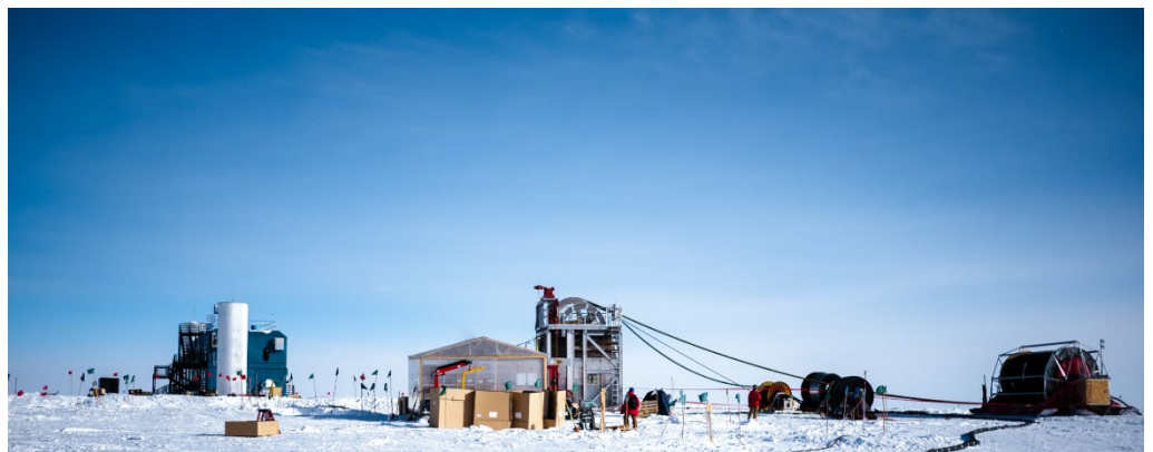
図6 ドリル切削と埋設を行う建屋：掘削孔の位置に設置し、天井から検出器に接続するケーブルを降ろす。左奥に IceCube のコントロールセンターが見える。(photo: Aya Ishihara/IceHap)
