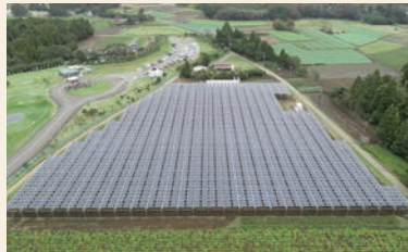
千葉市大木戸アグリ・エナジー1号機全景
