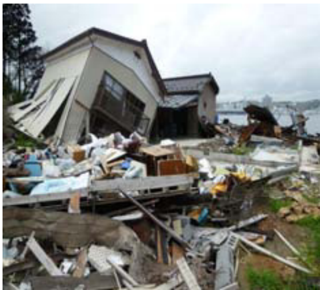
図1：H23 8/5 撮影 津波によって倒壊した家屋
